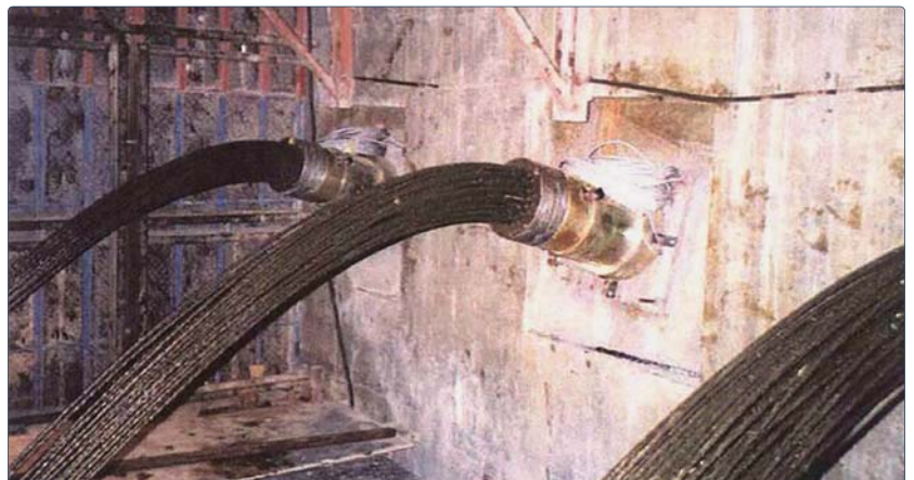
Celdas de carga de alta capacidad para anclas multi hilos utilizados en la retro adaptación sísmica de una presa.
