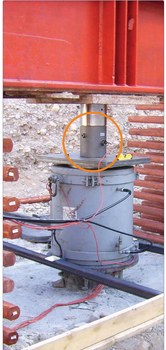
Una prueba de pila siendo realizada con una celda de carga de deformímetro de RST (rodeado) con una capacidad para 1,000 kips.
